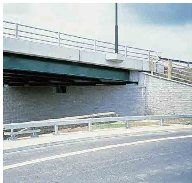
Kết cấu TensarTech đã được chứng nhận độc lập để sử dụng làm mô cấu chịu tải trong các ứng dụng đường cao tốc ở Anh.
