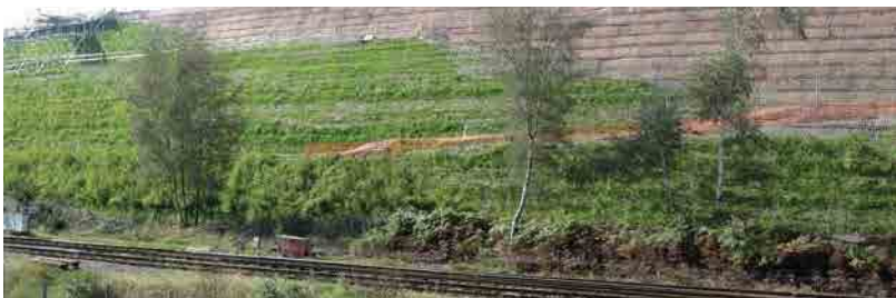
Với việc xây dựng thành công, TensarTech GreenSlope đã sẵn sàng cho giai đoạn trải thảm thực vật.
