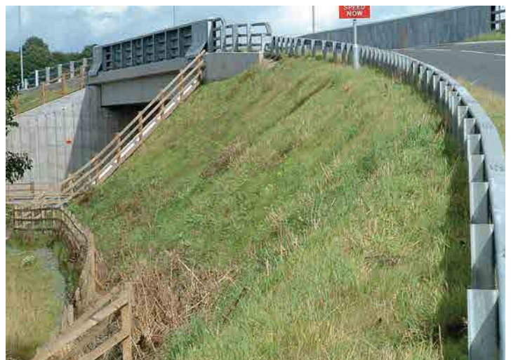
Kết cấu giúp thời gian thi công ngắn hơn và giảm gián đoạn giao thông.
