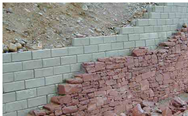
Mặt ngoài đỉnh kèm như lớp hoàn thiện bằng đá cát kết này có thể dễ dàng bố trí - hoàn thiện bằng cách sử dụng kết cấu tường chắn TensorTech TW với các mối nối bằng thép không gỉ.
