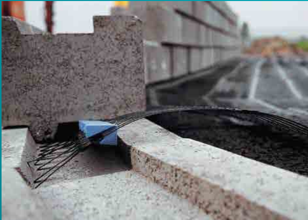
Một tính năng phổ biến cho tất cả các Kết cấu Tường chắn của TensarTech® là hiệu quả cao của mối liên kết giữa lưới địa kỹ thuật và bề mặt tường
