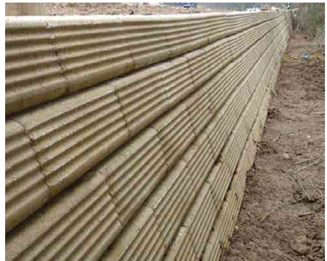
Liên kết hiệu quả cao giữa lớp phủ TensarTech® SlopeLoc™ và lưới địa kỹ thuật Tensar.
